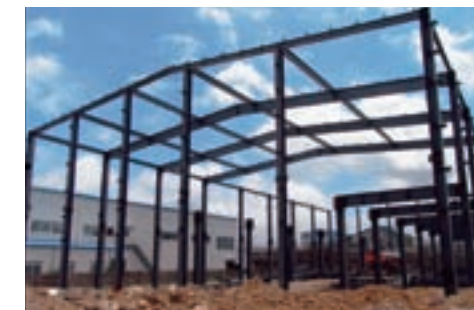
新設設備の建設現場
